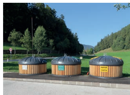
In Signat werden bei der Abzweigung zum Güterweg Ramml die Sammelglocken für die Sammlung von Papier, Glas und Dosen mit Halbunterflurcontainern ersetzt (im Bild jene vom Parkplatz Zentral in Klobenstein).
